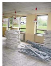
Im Speiseraum wurde eine Trennwand für den Sprachfördererraum errichtet, Decken werden eingezogen, um die neu installierten Heizungsrohre zu verstecken.
