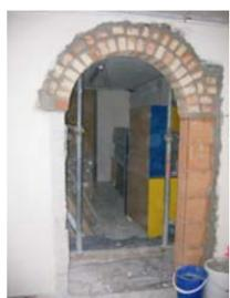
Der Eingang in einen neuen „Ausweichraum“ wird mit einem Rundbogen versehen.
