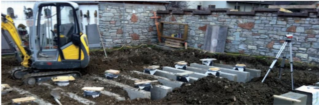
Bei der Erweiterung des Urnenfriedhofes werden im Bauabschnitt 1 zwölf Erdurnengräber und zwölf Grabstellen errichtet und für weitere 19 Grabstellen die Fundamente vorbereitet sowie die notwendigen Wege und Plätze in diesem Bereich mit Kleinsteinpflaster ausgeführt. Im Bauabschnitt 2 werden die bestehenden bekiesten
